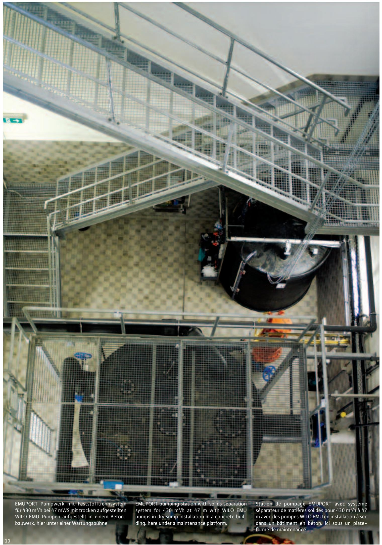
EMUPORT Pumpwerk mit Feststofftrennsystem für 430 m<sup>3</sup>/h bei 47 mWS mit trocken aufgestellten WILO EMU-Pumpen aufgestellt in einem Betonbauwerk, hier unter einer Wartungsbühne
