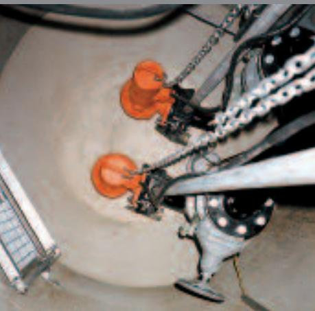
Pumpwerk mit Führungsstangen und Aufzugsketten
