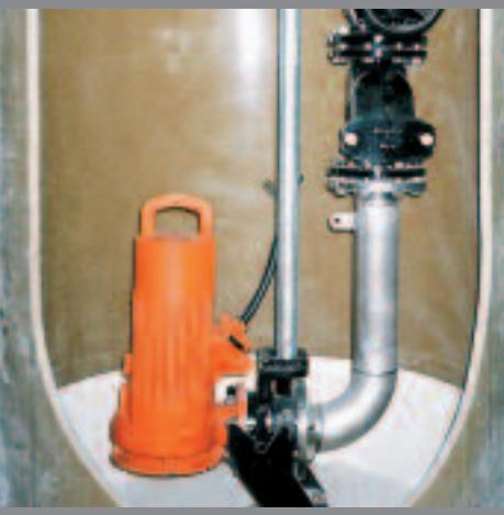
Pumpwerk – selbstkuppelnde Einhängevorrichtung
